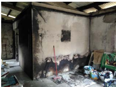
Chantier APRAH à Plum
