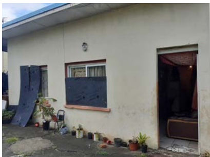
Chantier APRAH à Montravel
